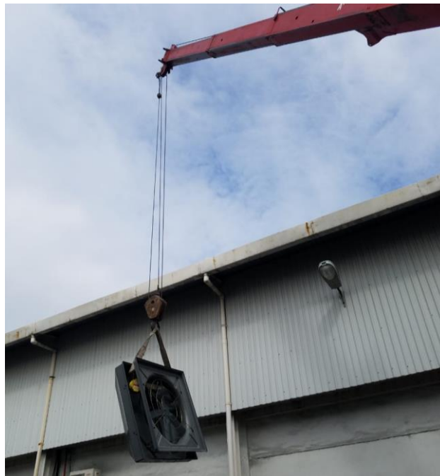
Ilustración 9 Izaje de los extractores
