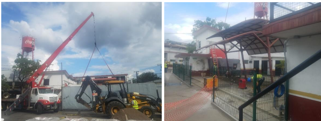
Ilustración 11 Izaje de estructura de techo
