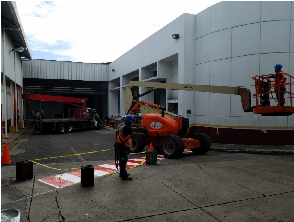
Ilustración 5 Prueba del equipo de elevación
