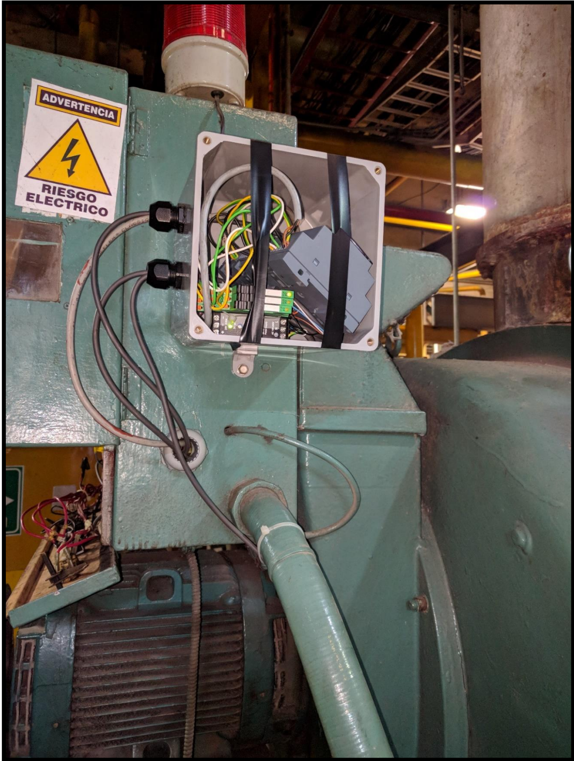
ANEXO 6. MONTAJE DE PRUEBA SISTEMA AUTOMATIZADO EN CALDERA #4 DE BIOGÁS
