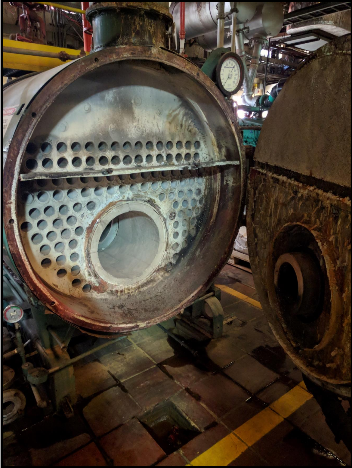
ANEXO 8. REPARACIÓN POR SOBRECALENTAMIENTO EN CALDERA #4 DE BIOGÁS
