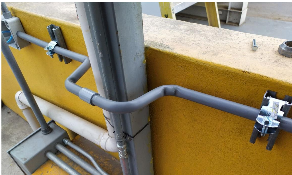
Ilustración 37-Colocación de tubería Conduit
