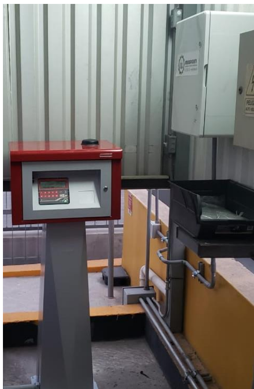
Ilustración 39-Instalación de GK-7+ y panel de control GENIUS
