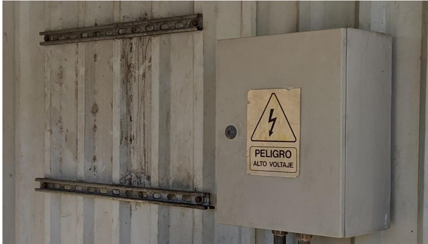
Ilustración 35-Instalación de panel de control Tegucigalpa
