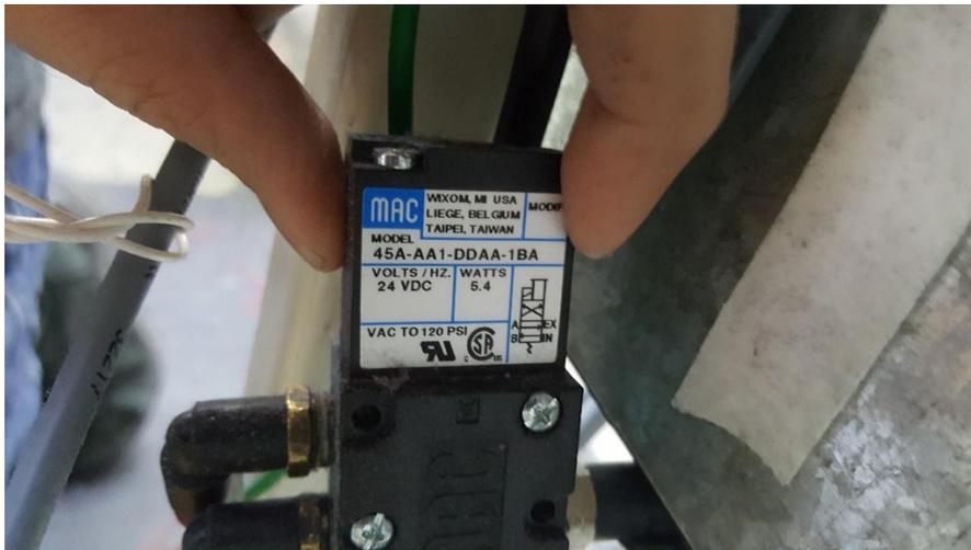
**Ilustración 28 - Instalación de las electroválvulas para el pistón del alineador**
