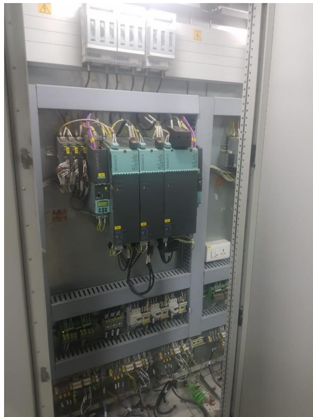
Anexo 28_Componentes drive line panel.
