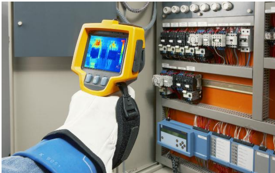
Ilustración 7. Medición de temperatura por cámara termográfica
