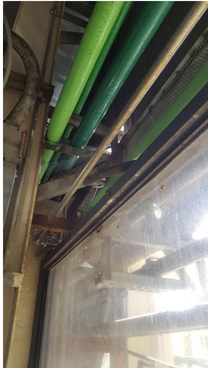
Anexo 6 - Antigua tubería de aire comprimido fuera de servicio
