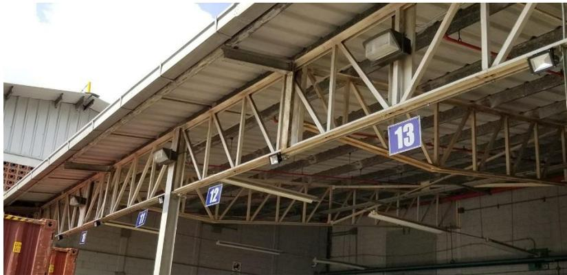
**Ilustración 12: Sistema de luces de señalización instalado**
