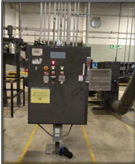
**Ilustración 13-Tablero eléctrico utilizado en máquinas volteadoras**
