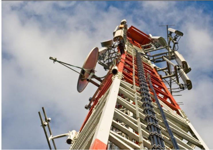
Ilustración 1. Torre de Telecomunicaciones
