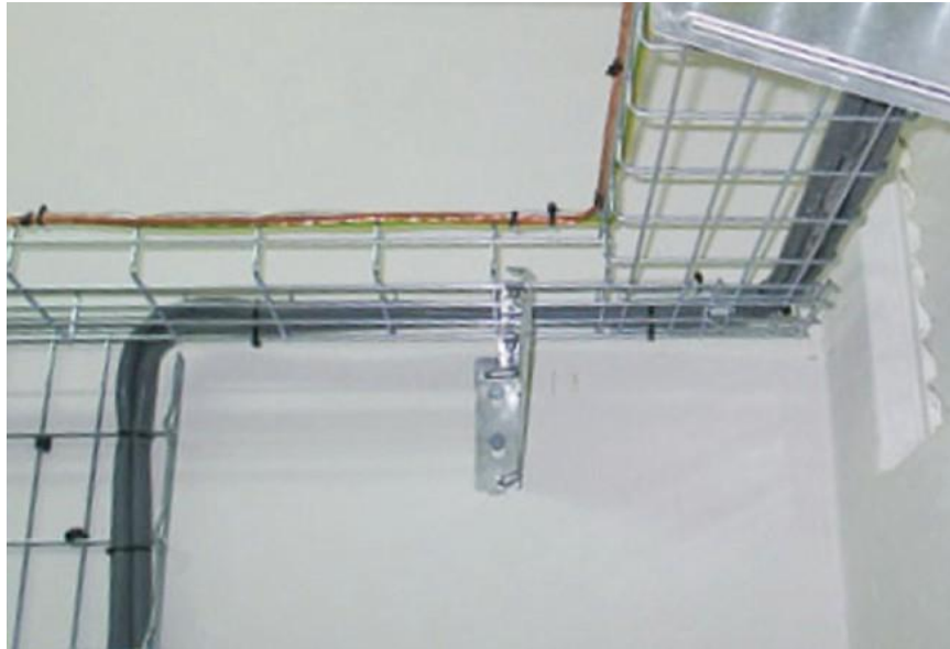
Ilustración 13. Bandeja perimetral dentro de recinto
