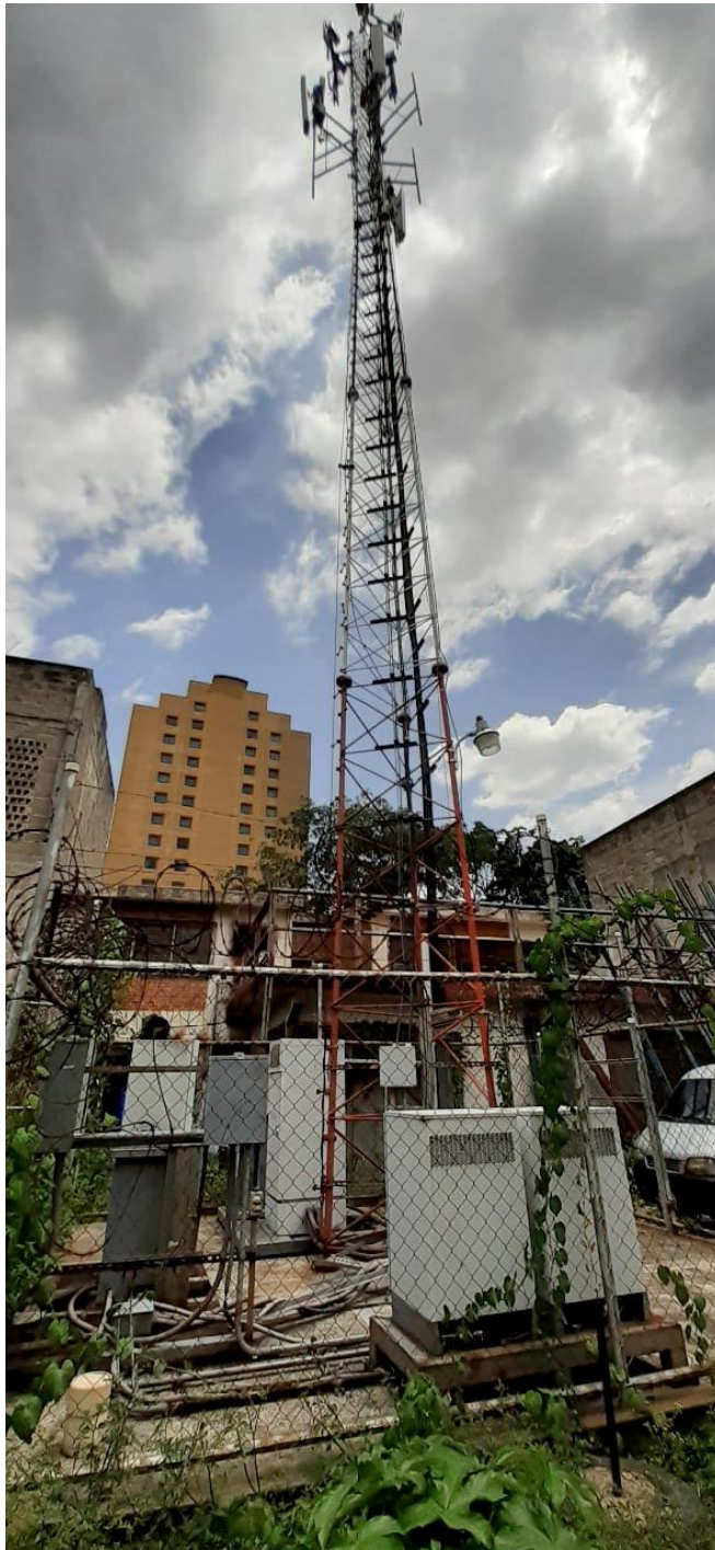
Ilustración 19. Torre de sitio auditado
