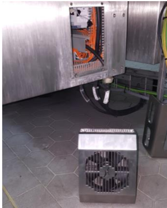
Ilustración 24. Desmontaje de ventiladora de Linatronic línea #3
