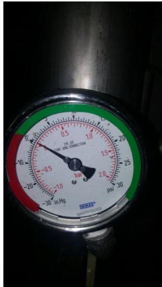
Ilustración 29. Actividad de marcación de rangos de manómetros.
