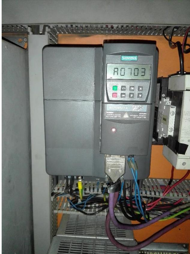
**Ilustración 18: Instalación de Nuevo Variador Bomba de Bunker**
