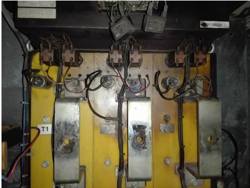
**Ilustración 14: Daño en el convertidor**
