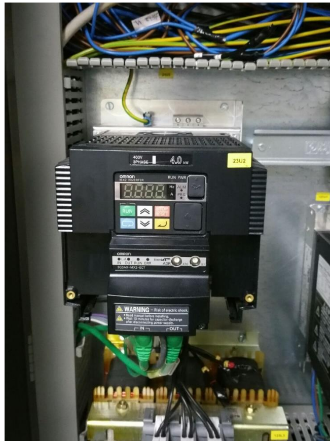
Foto #3 Servomotor OMRON usado de referencia en Maquina de corte RLA
