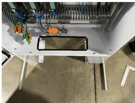
Ilustración 117. Corte al panel eléctrico.
