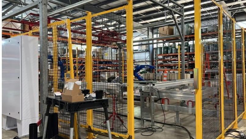
Ilustración 116. Montaje de guarda de seguridad.
