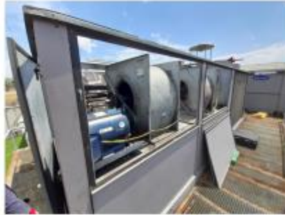
Figura 1: CHILLER DE UNIDAD DE PAQUETE
