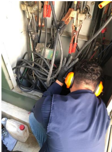
Ilustración 15. Pruebas en transformador utilizando equipo de seguridad
