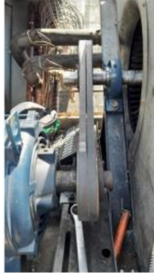
Figura 4: BANDAS MONTADAS-EQUIPO ALINEADO
