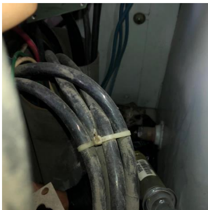
Ilustración 16. Extracción de válvula principal
