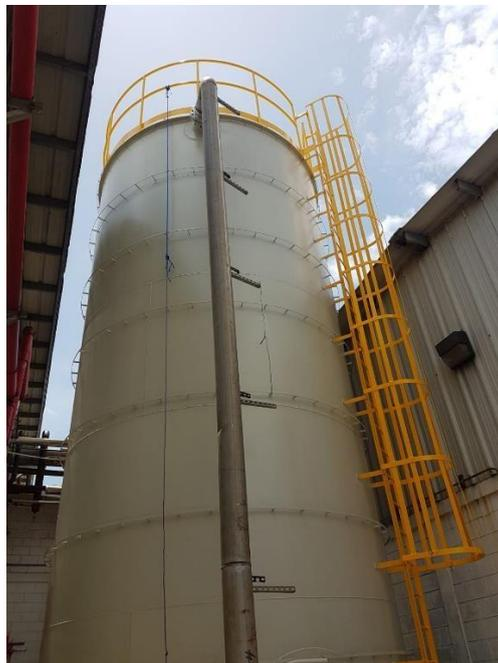
**Ilustración 25. Ruta de tubería para cable**
