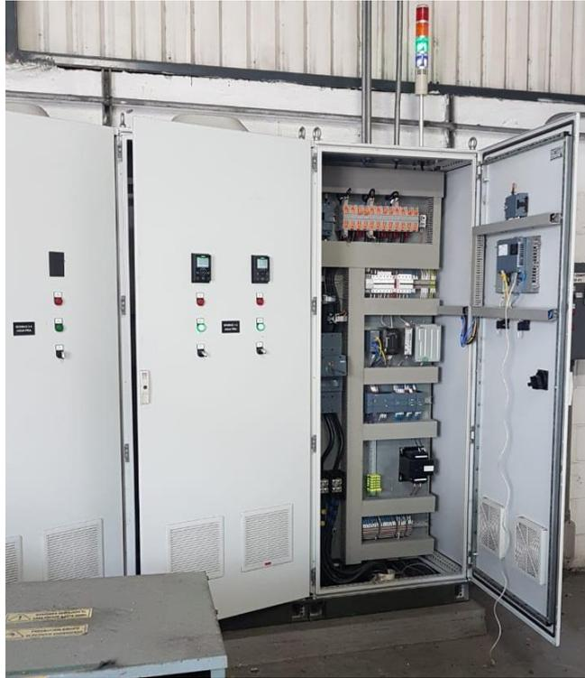
**Ilustración 17. Tablero de fuerza y control de bombas RN3**
