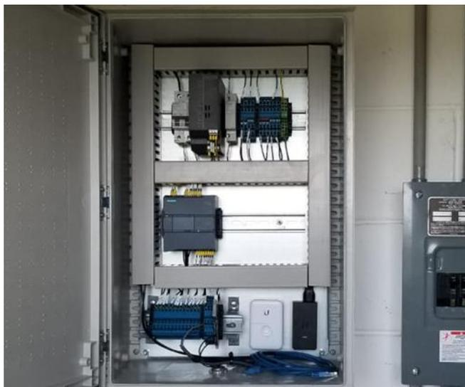
**Ilustración 53- Panel eléctrico pozo #10**
