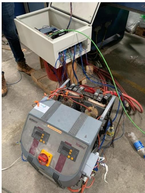
**Ilustración 6- Chiller con nuevo Control de Mando incorporado**
