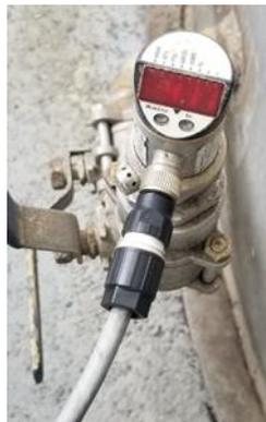
**Ilustración 27- Sensor de presión PI2898**
