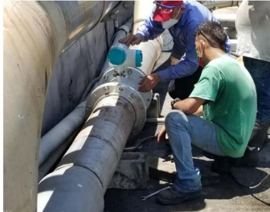
***Ilustración 51- Instalación del caudalímetro electromagnético***
