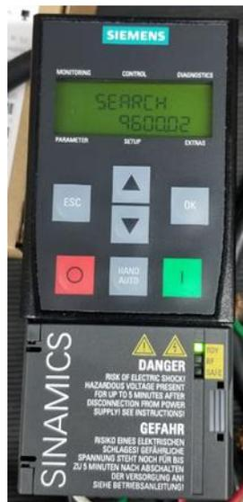
**Ilustración 23- Variador de frecuencia G120C**
