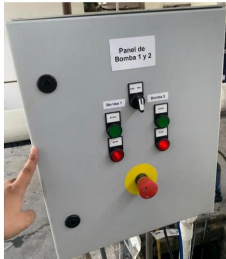
**Ilustración 29-Panel de control de bombas**
