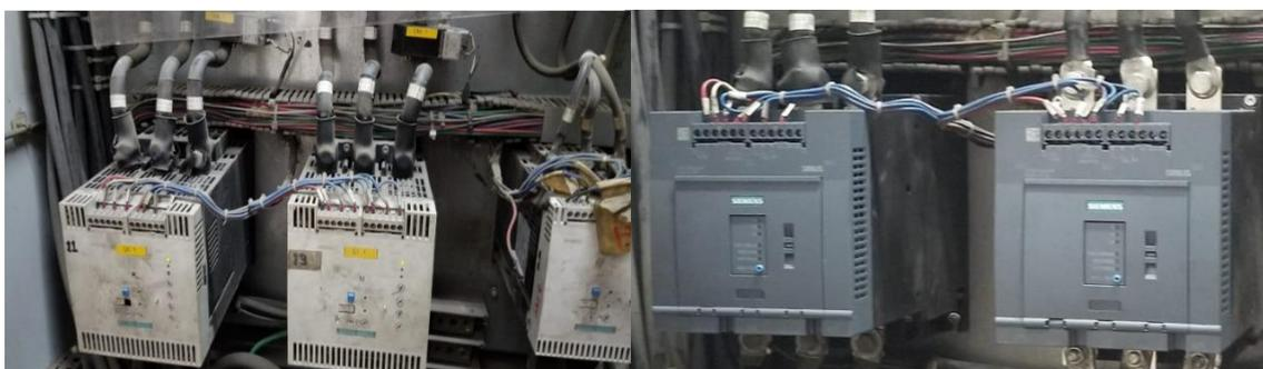
**Ilustración 31- Antes y Después del cambio de arrancadores suaves**
