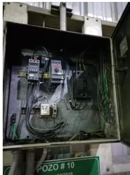
Figura 5. Panel de Control de pozo 10
