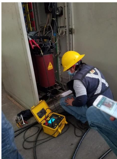
Ilustración 26 Realizando el análisis de aislamiento y funcionamiento de los transformadores.
