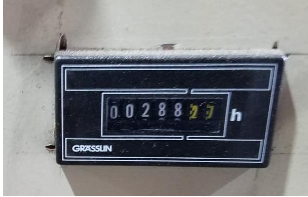
Ilustración 18 Instalación de horómetro.
