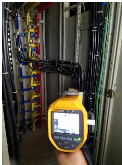
Ilustración 23 Toma de imagen con la cámara termográfica.
