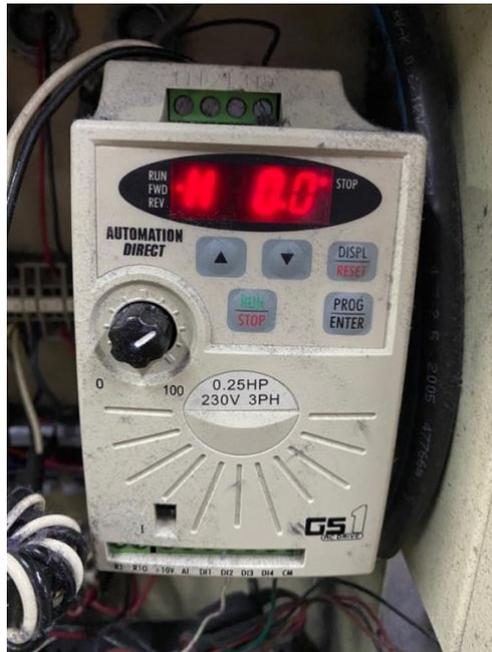
**Ilustración 6- Variador de Frecuencia GS1**
