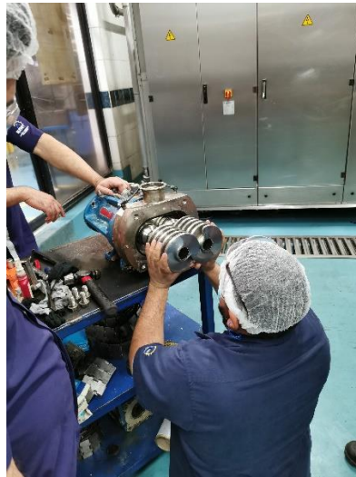
Ilustración 37: Cambio de Balineras y Sellos en Bomba
