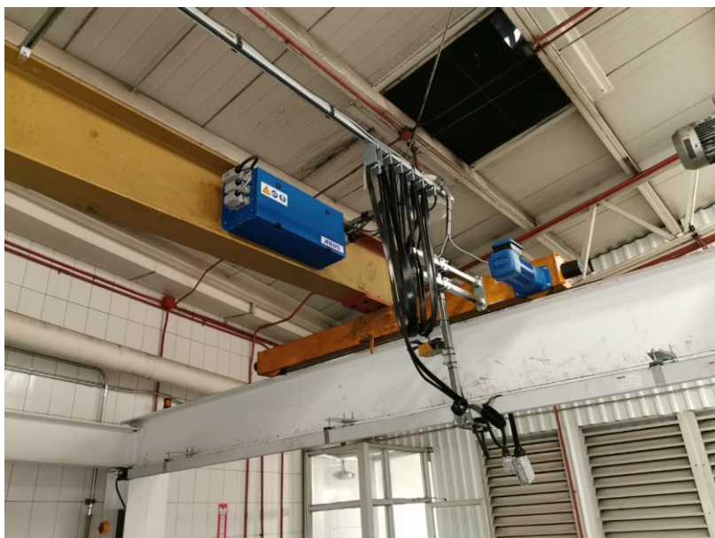
Ilustración 26: Nuevo Panel Montado con Conexiones
