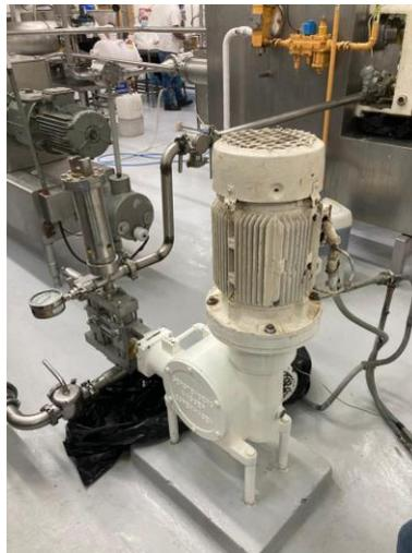
**Ilustración 4. Bomba de alta presión Olepsa**
