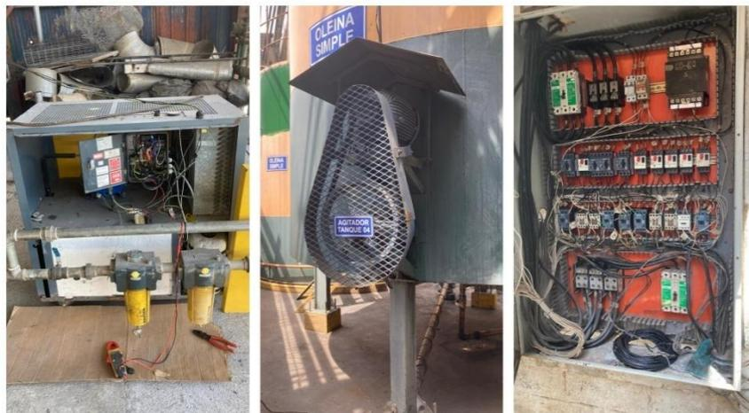
**Ilustración 28. Reparación compresor y colocación de línea agitador**
