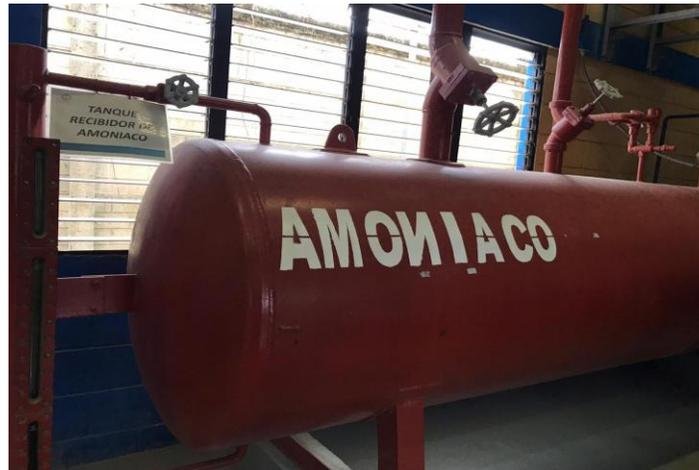
**Ilustración 14 - Tanque receptor de amoníaco**
