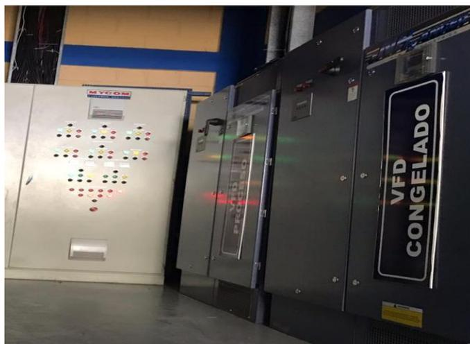
**Ilustración 15 - Panel de control de los sistemas de refrigeración**
