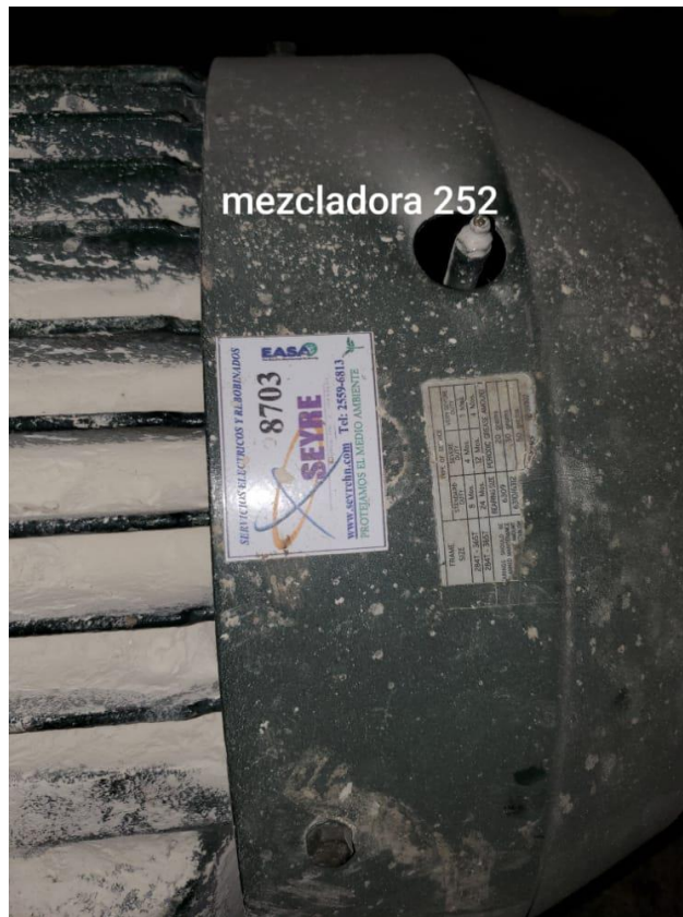
Ilustración 8- Motor rebobinado que presentaba fallas
