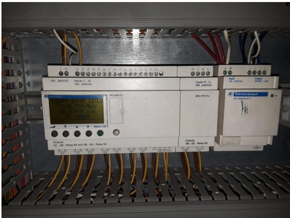
Ilustración 13- PLC Instalado en la empresa
