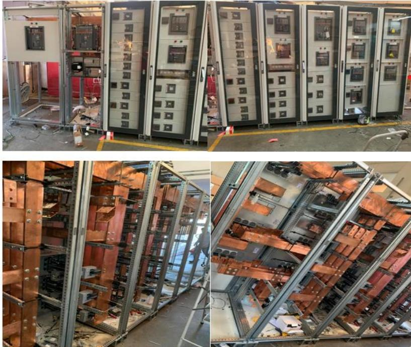
*Ilustración 22 SwitchBoard 6300<sup>a</sup>*
