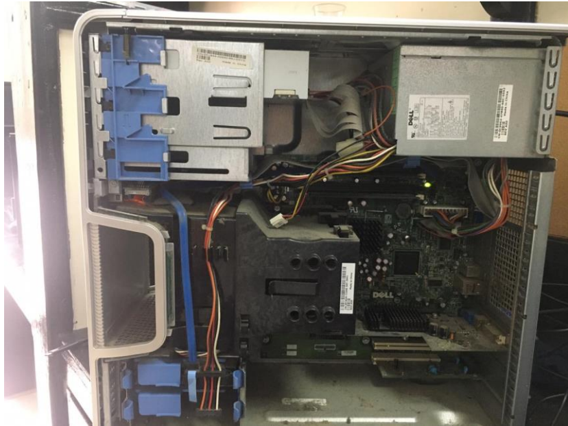
Ilustración 23. Computadora con placa madre defectuosa
