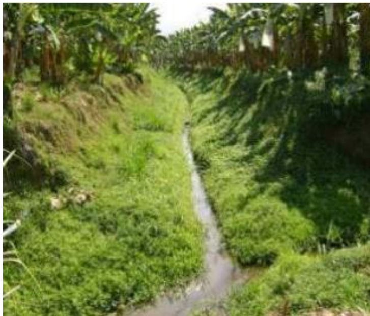
Ilustración 3. Canal primario de drenaje
