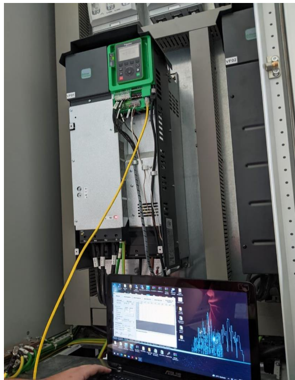
Ilustración 39 Lectura del Variador en RLA Manufacturing
