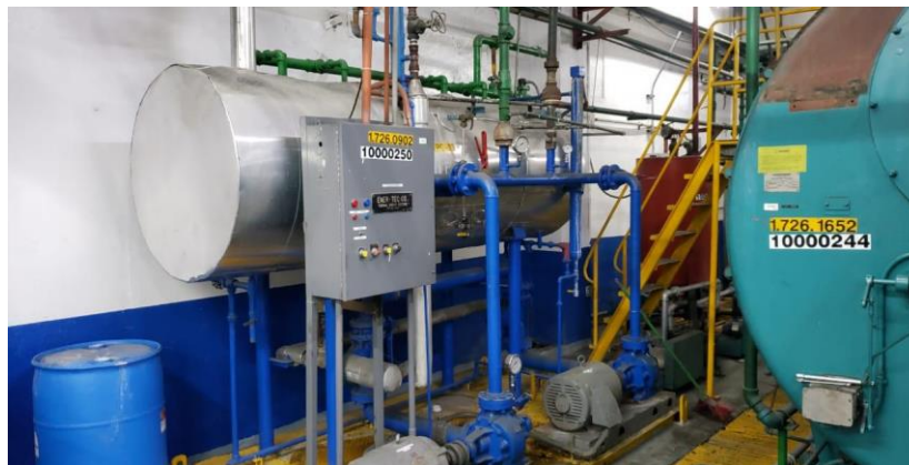
Ilustración 19 Tanque Precalentador
