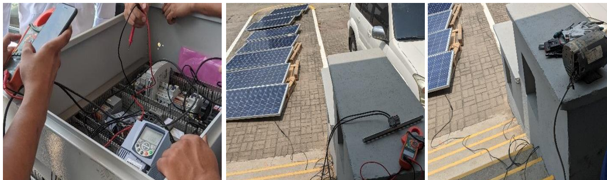
Ilustración 21 Revisión de motor energizado con paneles solares.
