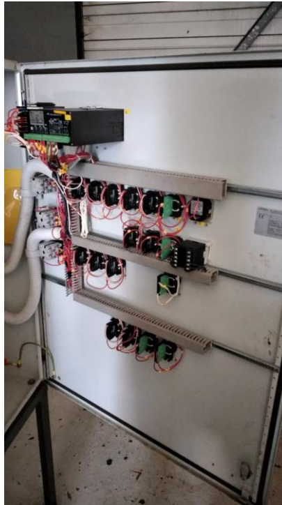
Ilustración 15 conexión eléctrica de alarmas y selectores
