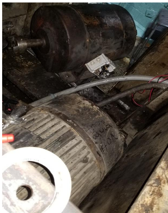
Ilustración 18: Desmontaje de motores
