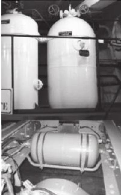
Ilustración 10 Depósitos de aire comprimido.
