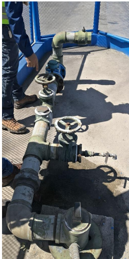
Ilustración 7 Levantamiento del área de pozos y cisternas Fuente: Propia.
