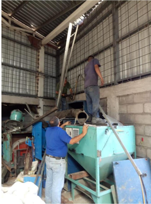
Ilustración 24. Instalación de líneas 480V
