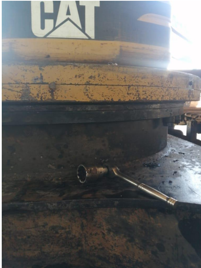
Ilustración 37: Extracción de pernos para desacople de tornamesa con estructura de orugas
