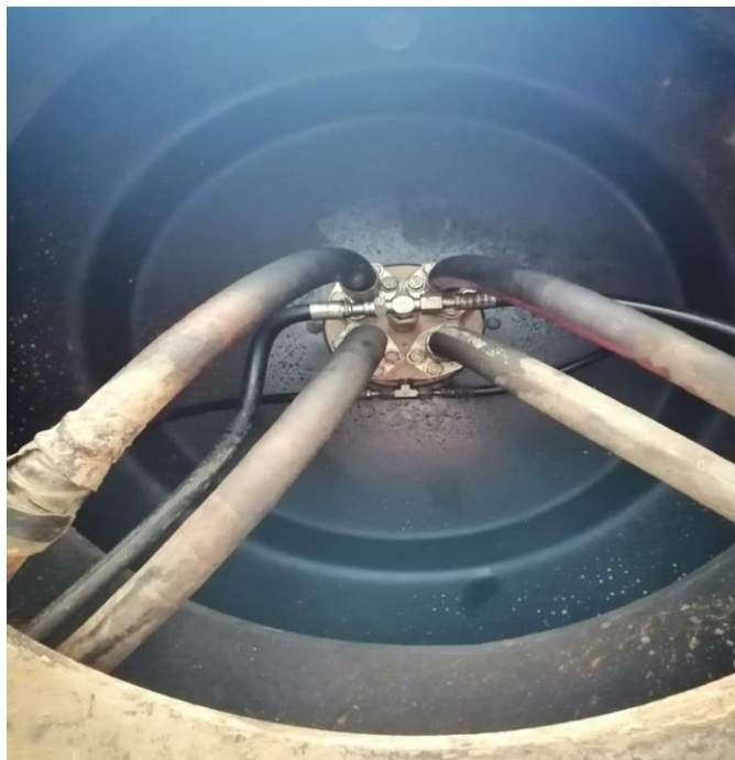
Ilustración 52: Acople de mangueras hidráulicas de orugas a la parte inferior de la junta giratoria central
