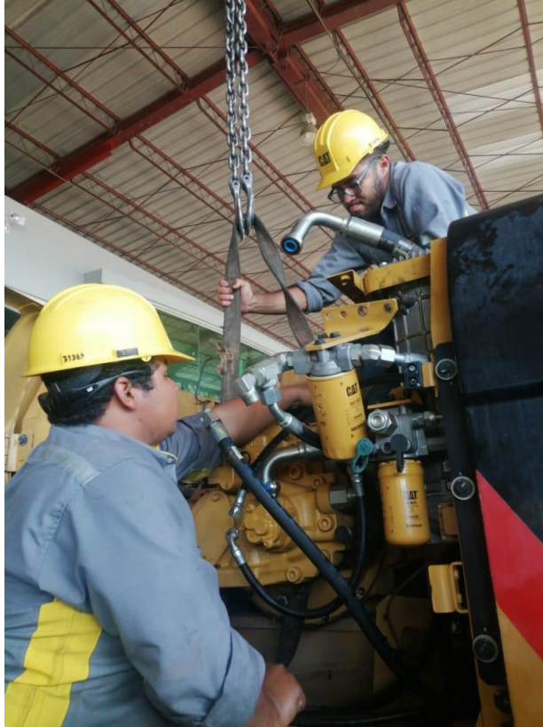
Ilustración 72: Bomba hidráulica sujeta con eslinga para elevación junto a tecla eléctrica
