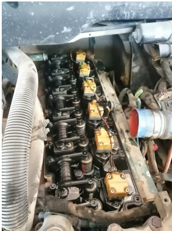
Ilustración 105: Colocación de inyectores luego de reparación
