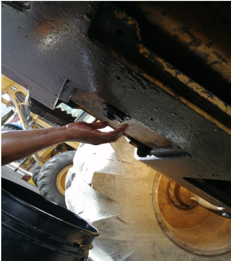
Ilustración 22: Vaciado de aceite de caja de transmisión
