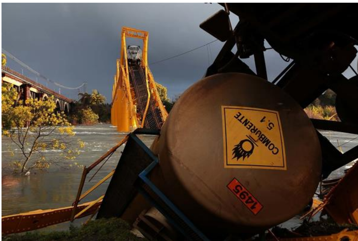
Ilustración 4 Contaminación por Soda Cáustica
