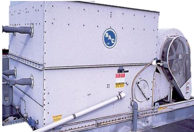
**Ilustración 12. Condensador evaporativo tipo VC2-1160S de marca BAC**
