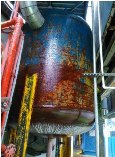
**Ilustración 16. Separador de baja presión**
