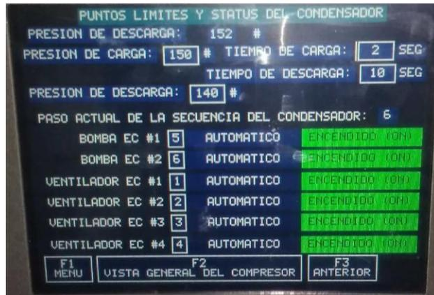
**Ilustración 20. Interfaz del controlador Allen Bradley para los condensadores BAC**
