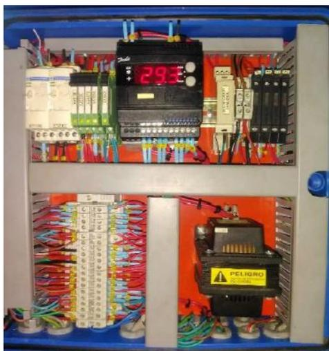
**Ilustración 19. Controlador Danfoss EKC361 para los evaporadores VMC y Hansa**
