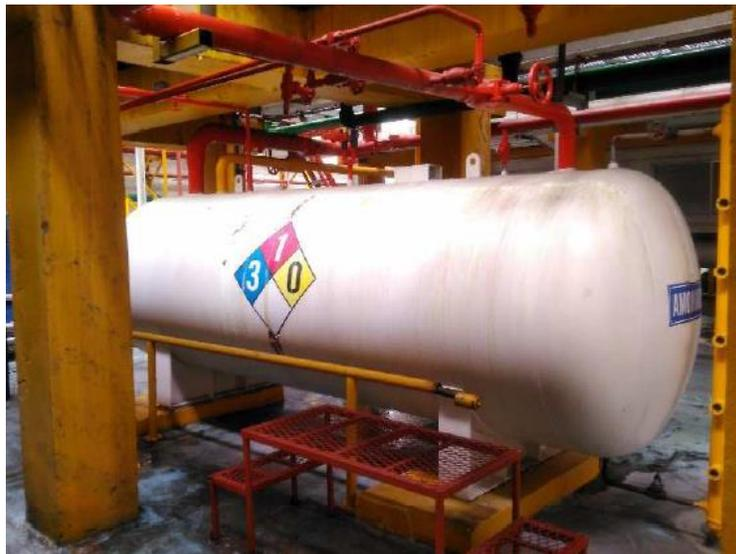
**Ilustración 15. Tanque recibidor o de alta presión de marca Nickell**
