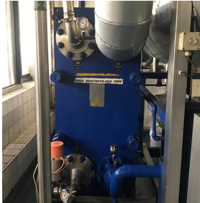
**Ilustración 30. Intercambiador de calor de marca Alfa Laval en la línea de producción #3**
