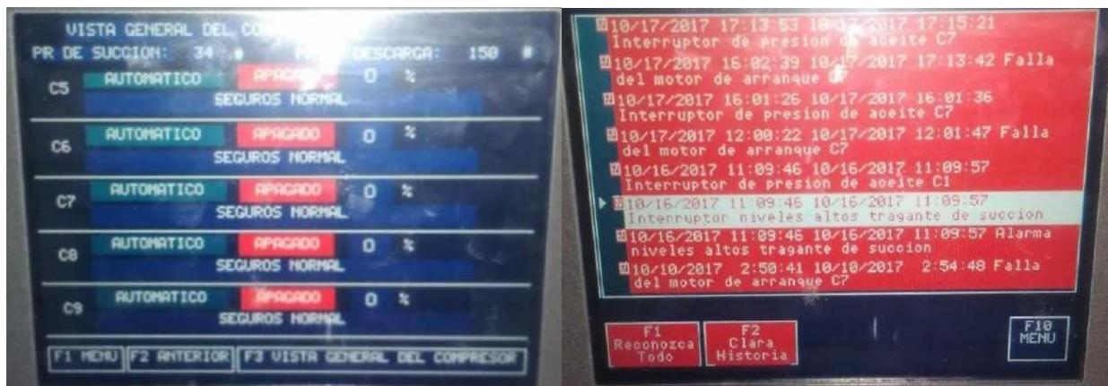
**Ilustración 18. Interfaz del controlador Allen Bradley para los compresores Vilter**
