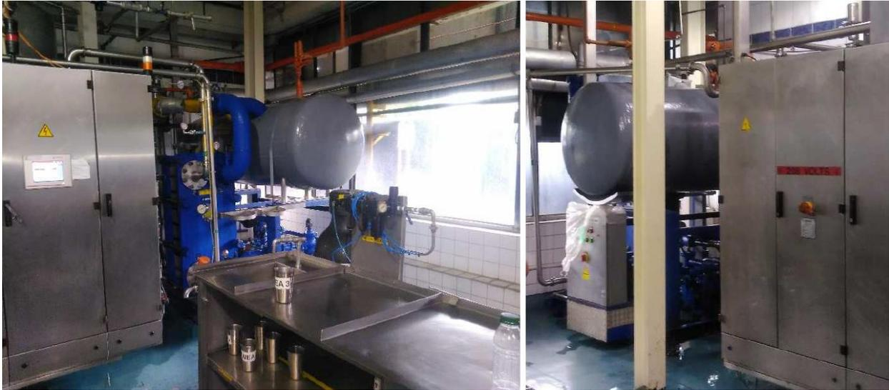
**Ilustración 26. Unidad de almacenamiento de amoníaco sin cubrimiento aislante**
