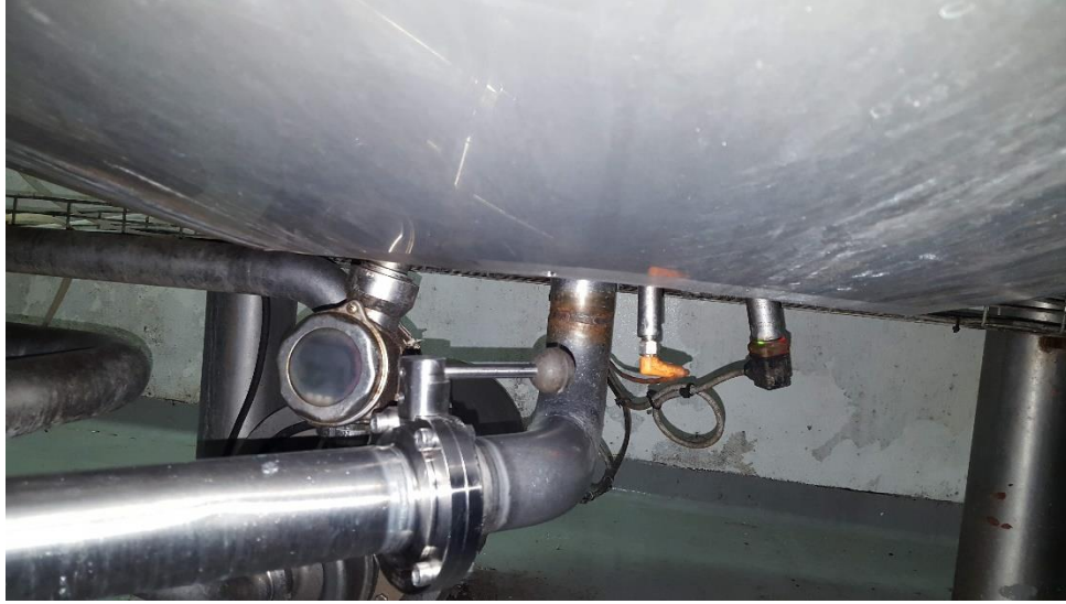
Ilustración 19. Instalación de los sensores de presión, temperatura y de nivel en parte inferior de tanques ya automatizados
