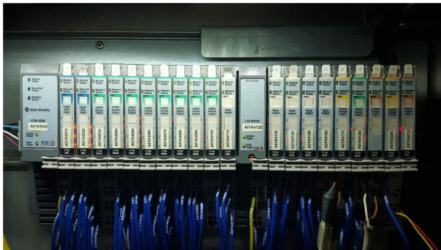
Ilustración 22. Módulo remoto Point con sus E/S analógicas y digitales
