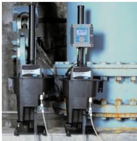
**Ilustración 18. Analizador de turbidez HACH**
