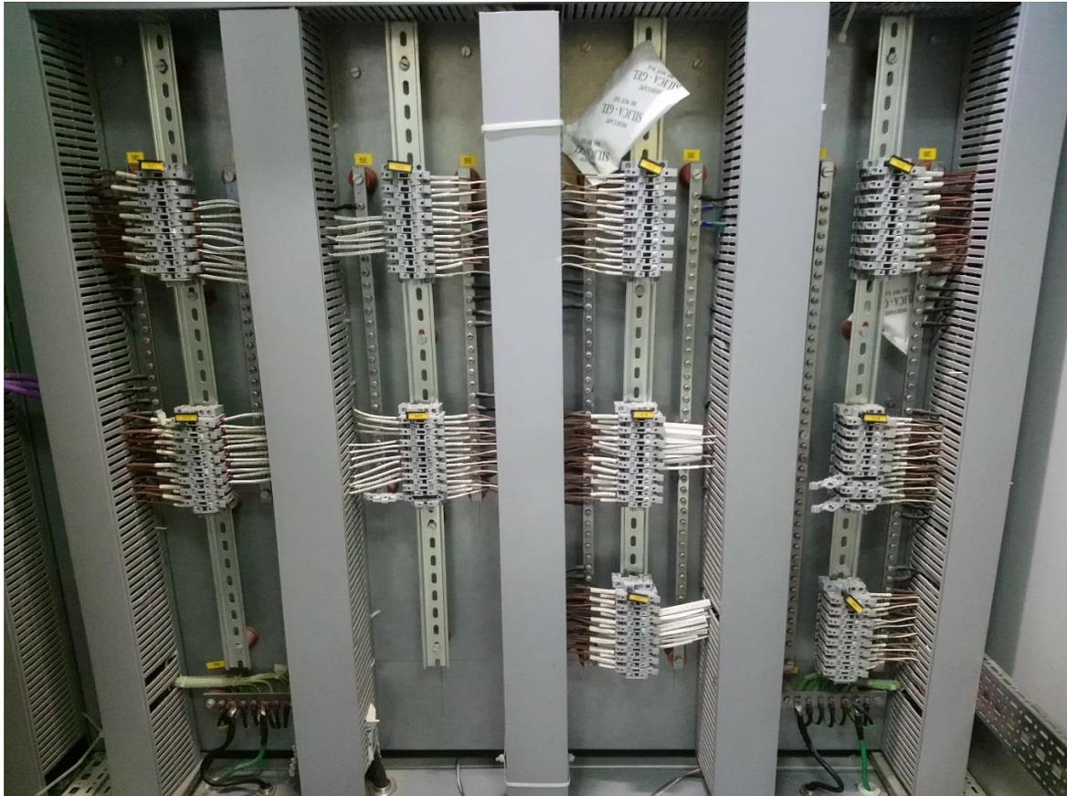
**Ilustración 26. Borneras en gabinete en el cuarto de control**
