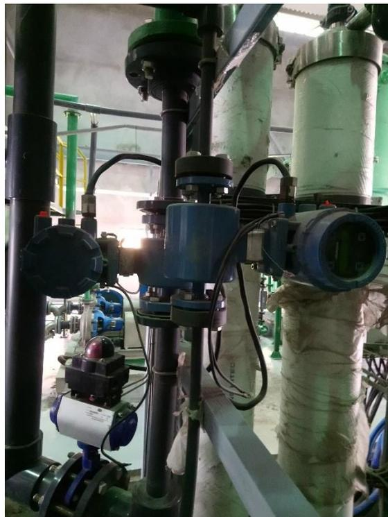
**Ilustración 24. Transmisores de flujo ya instalados**
