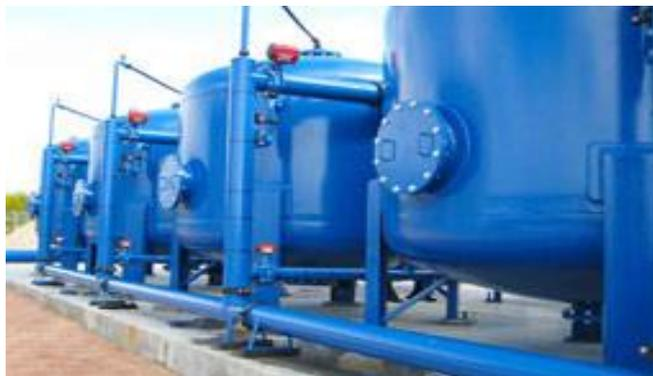
**Ilustración 6. Filtros multigrados juntos**
