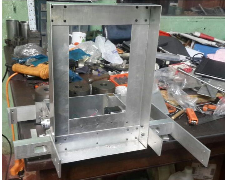
Ilustración 40 - Armado de estructura de aluminio.
