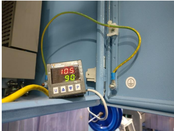
Ilustración 39. Prueba de la PT100 de la Secadora
