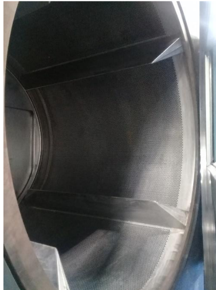
Ilustración 30. Instalación de Cesto de acero inoxidable
