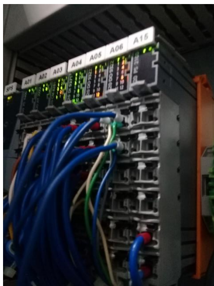
Ilustración 43. Instalación de los selectores
