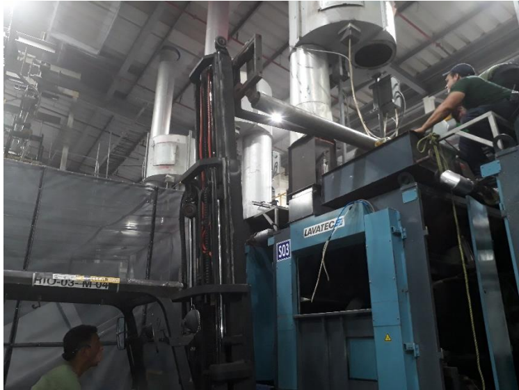
Ilustración 28. Instalación de tubería de vapor
