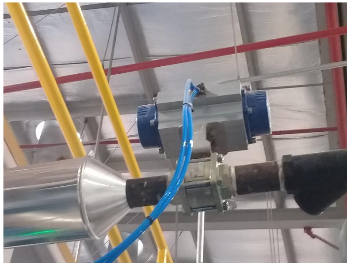
Ilustración 16. Actuador de presión
