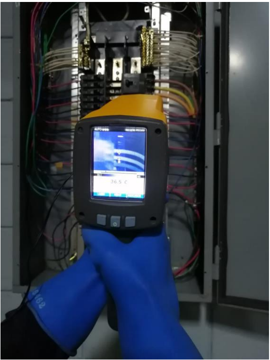
Ilustración 29-Mediciones de termografías.
