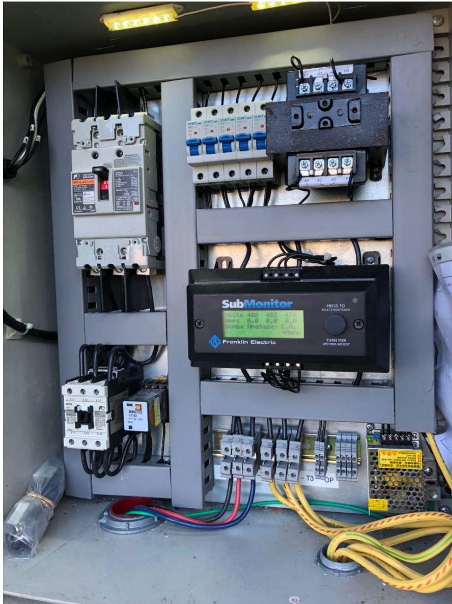
Anexo 1: Sistema de control cableado para pozos
