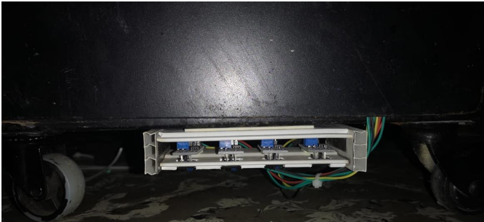
Figura 29 -Instalación de sensores
