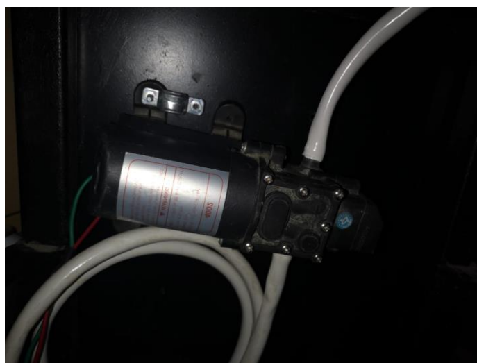
Figura 31 -Conexión de la bomba
