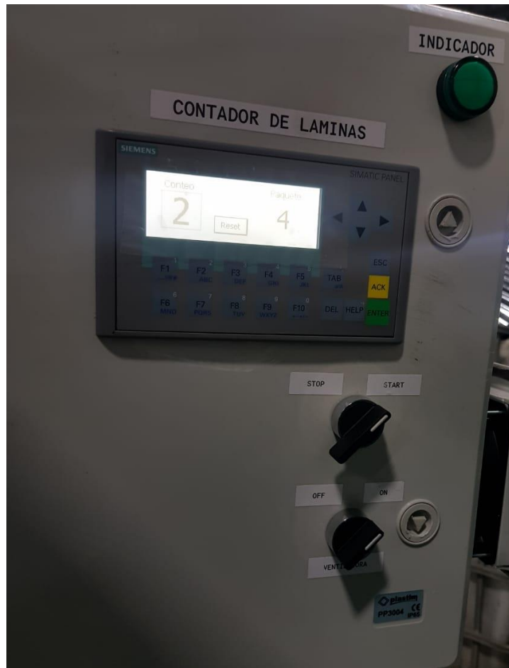
Ilustración 19. Realizando pruebas en contador de láminas
