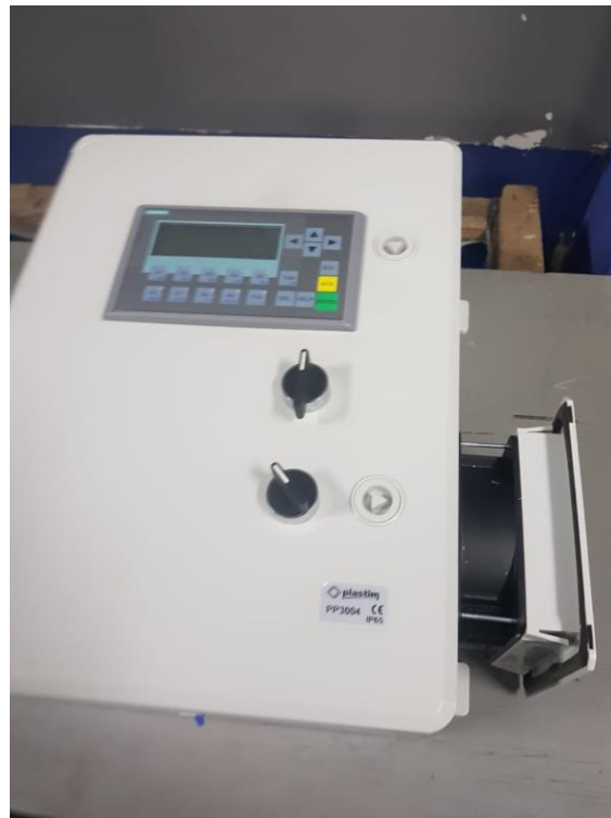
Anexo 2_Montaje selectores y ventiladora
