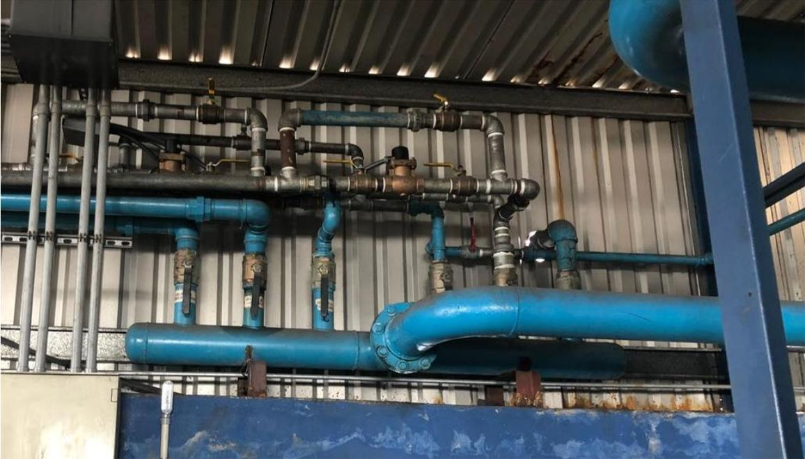
**Ilustración 14. Punto de distribución de aire comprimido para diferentes áreas de producción.**
