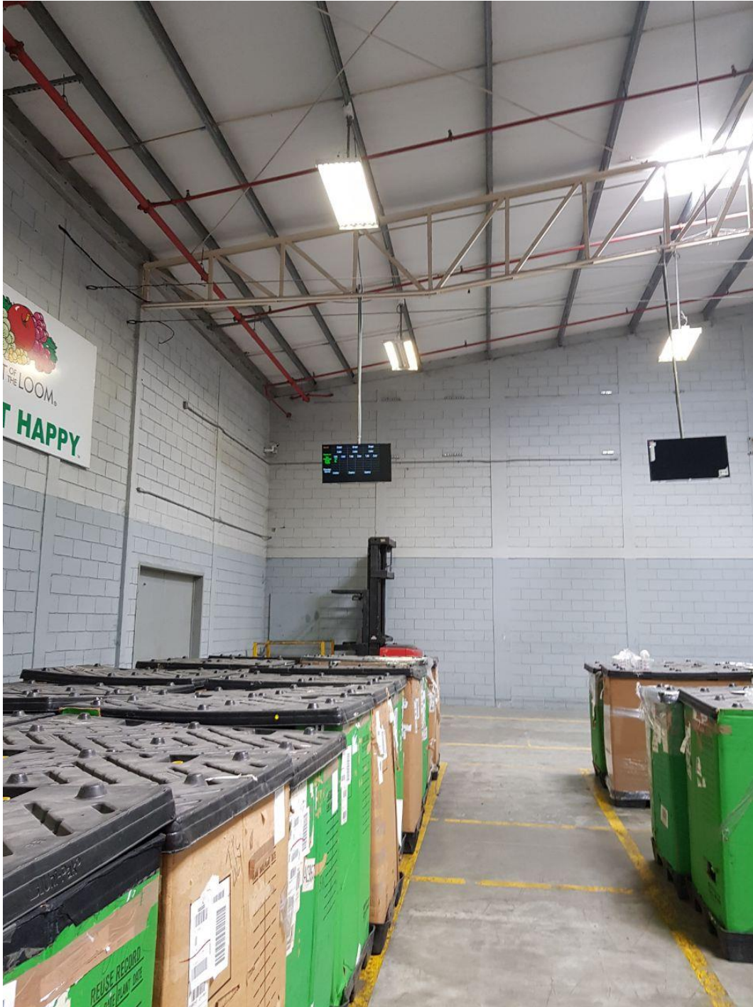
Anexo 8. Instalación de Sistema Andon de Producción
