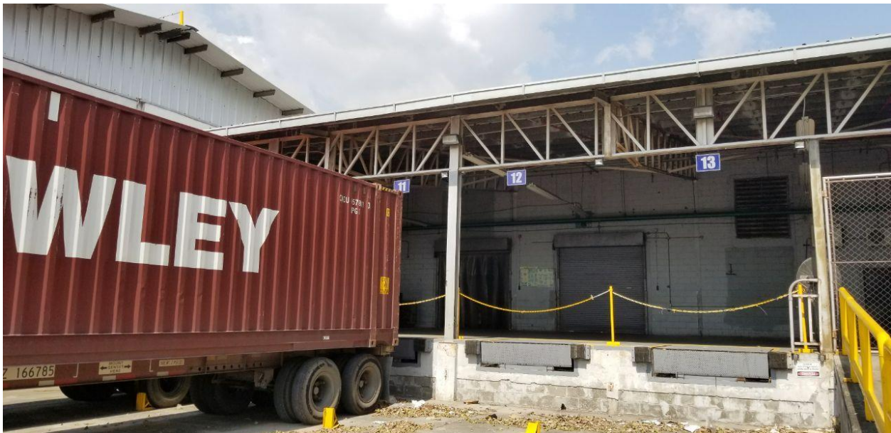
Anexo 6. Instalación de Sistema de Señalización para Control de Tráfico en Anden de Exportación.
