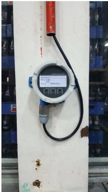
Anexo 6 - Display Remoto DKX001 para Línea de Producción No. 5
