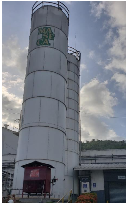
Anexo 2. Silos Diarios
