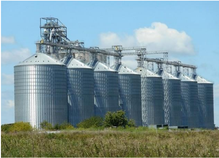
Ilustración 3. Silos de Conservación
