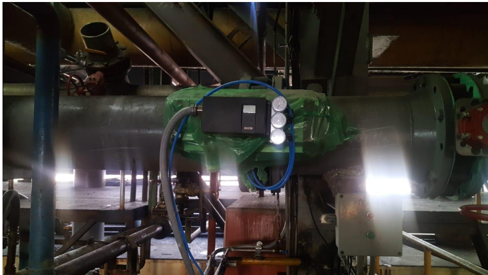
Ilustración 50 Actuator y posicionador electro neumático
