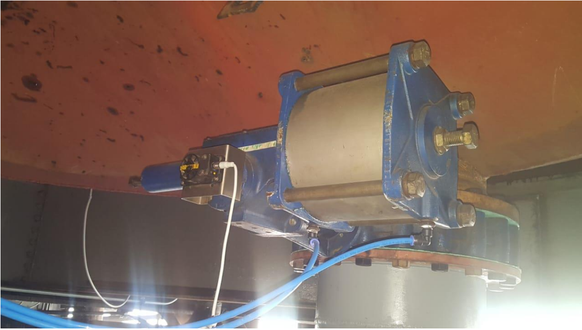
Ilustración 47 Hydrotrac, sensor de medición de brix.
