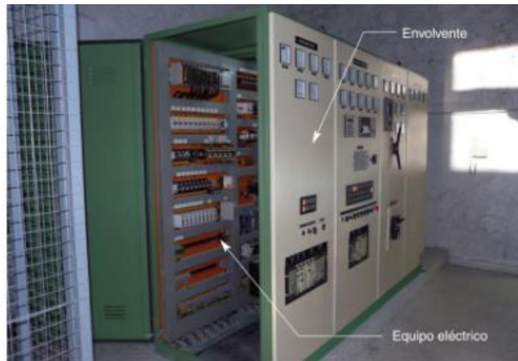
Ilustración 8. Elementos que constituyen un cuadro eléctrico
