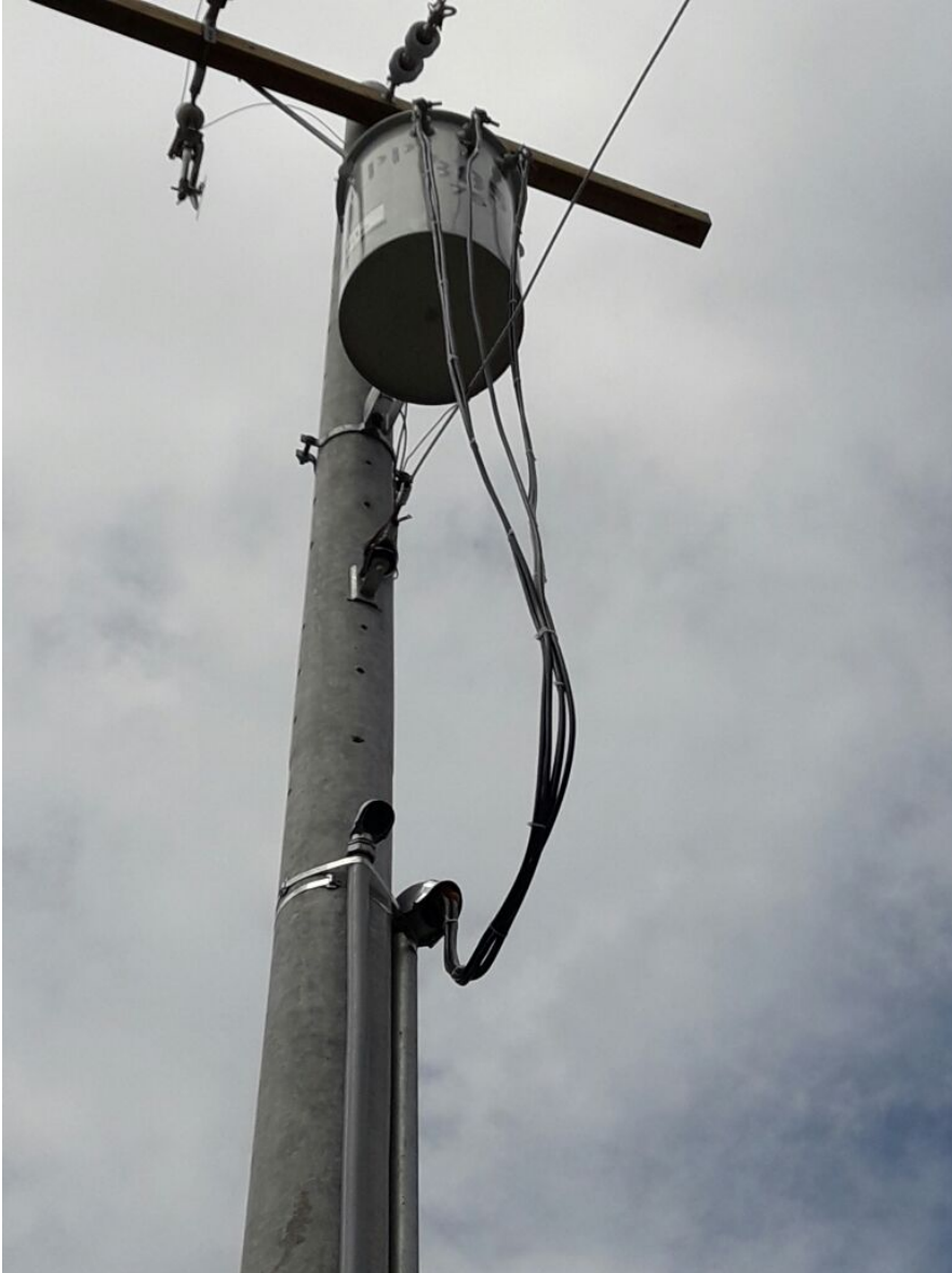
Ilustración 24 Transformador instalado
