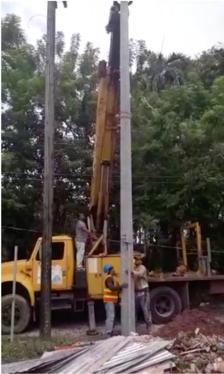
Ilustración 23 Levantamiento de Poste de concreto
