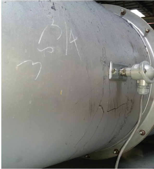
Anexo 8 - Instalación de PT100 en ducto de salida de aire exterior
