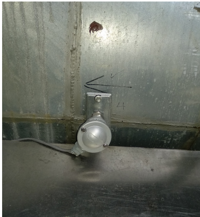
Anexo 7 - Instalación de PT100 en ducto de entrada de aire exterior
